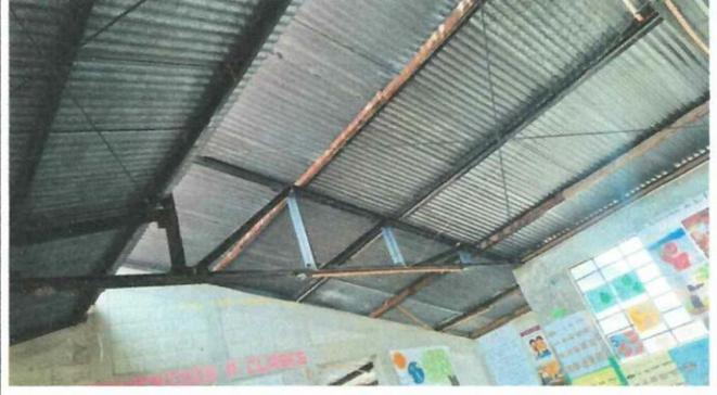
Foto 2: SUSTITUCION DE ESTRUCTURA DE TECHO
