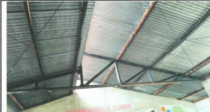
Foto 3: ESTRUCTURA DE TECHO APOYADO CON REGLAS DE MADERA
